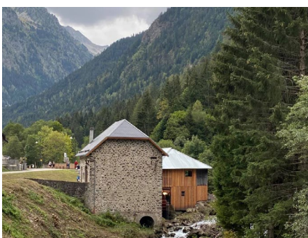
Remise en eau de l'ancienne scierie de Valjouffrey
